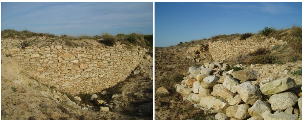
Detalle da muralla de pedra que protexe ao castro
